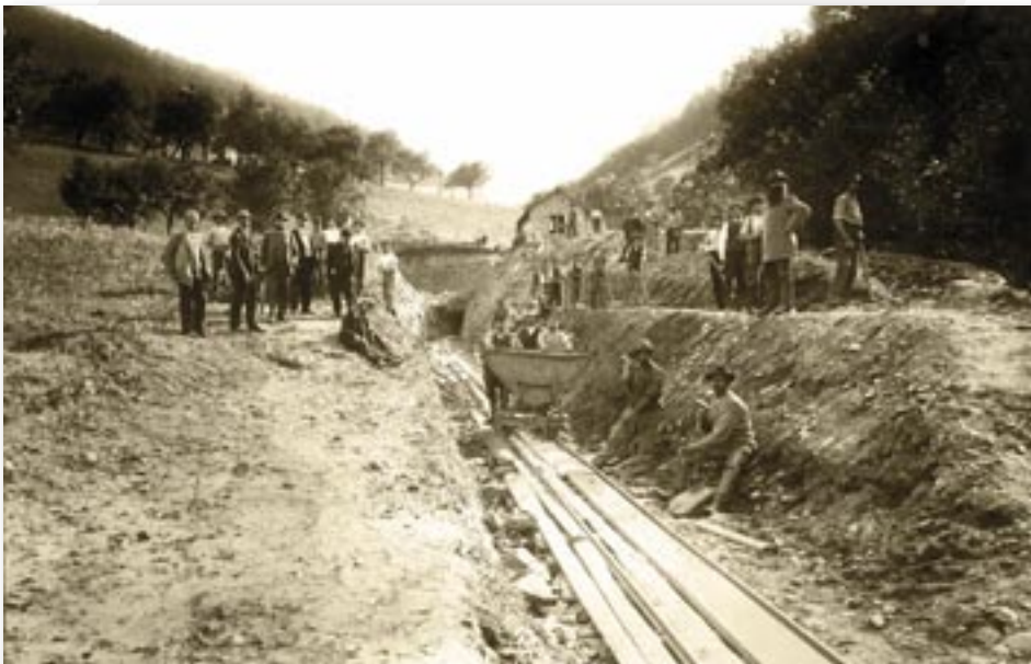
Réouverture de la mine Tiefstollen en 1898 dans le Rauenthal Coll. David Bouvier
